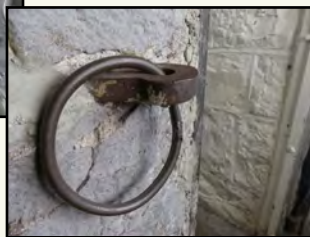
(Below) Holding ring front door
